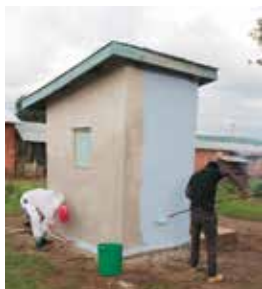
Wasserstation vorher und nachher.
